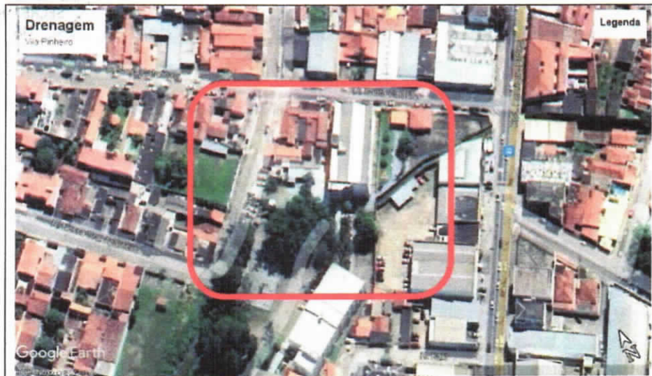
Foto 22: Ponto de inundação
