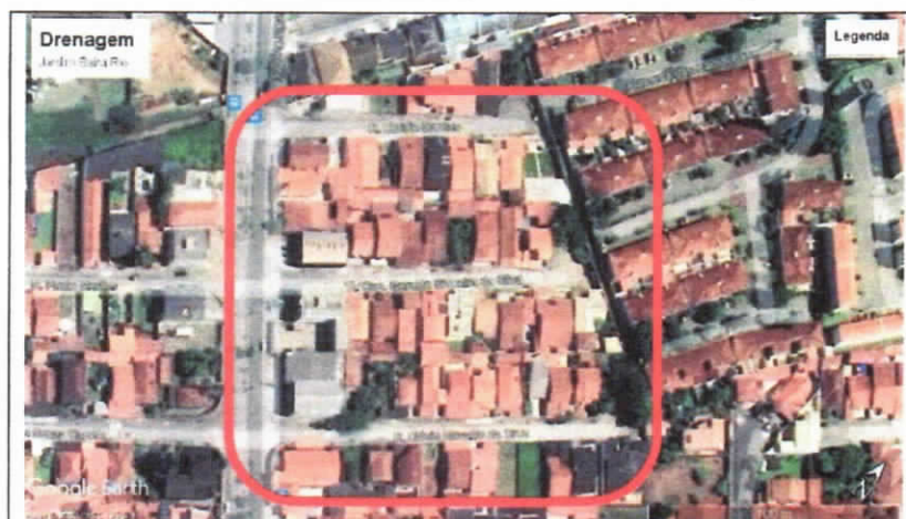
Foto 13: Local onde há problemas de alagamento
